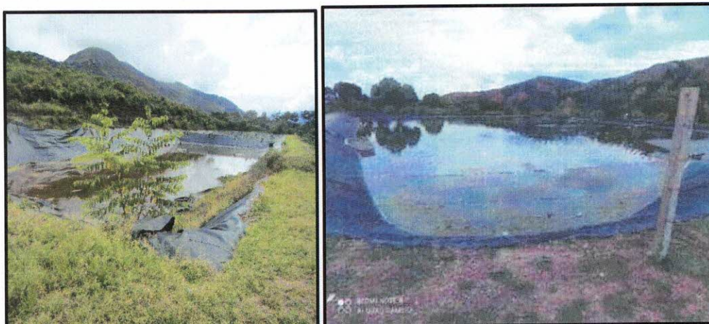
Figura 21. PTAR sector Timaruca - San Ignacio y Laguna efluente Planta Nueva - Jaén
