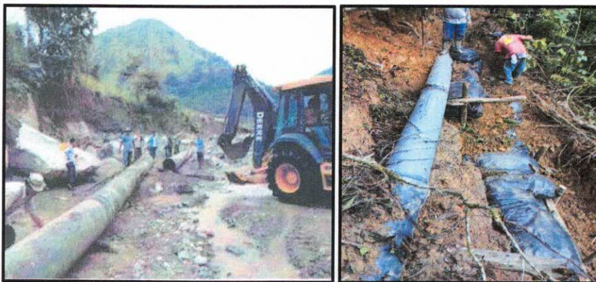
Figura 16. Trabajos de reposición de líneas de conducción e impulsión de Jaén y San Ignacio
