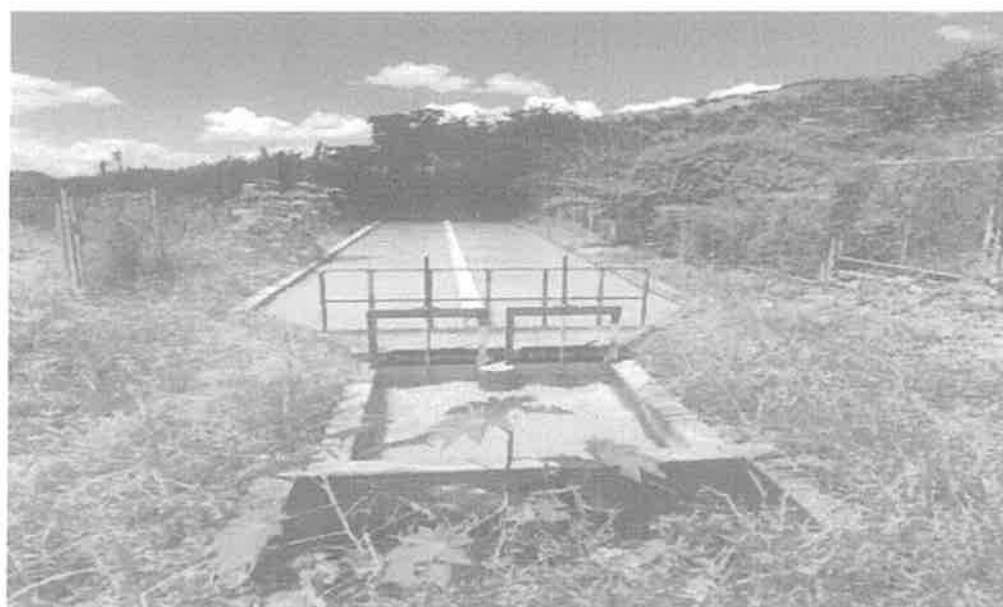
Imagen N°007: Desarenador
