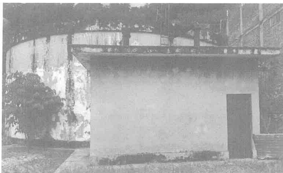
Imagen N°024: Reservoirio Morro Solar
