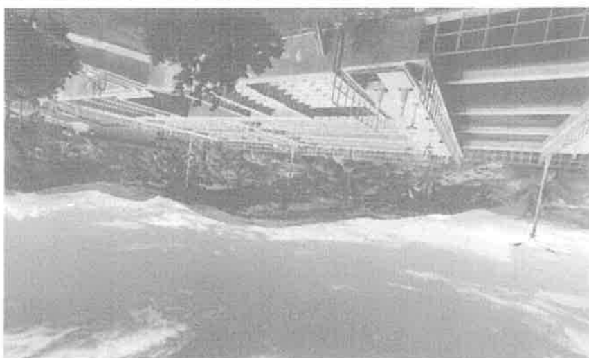
Imagen N°009: PTAP Nueva de la localidad de Jaén.
