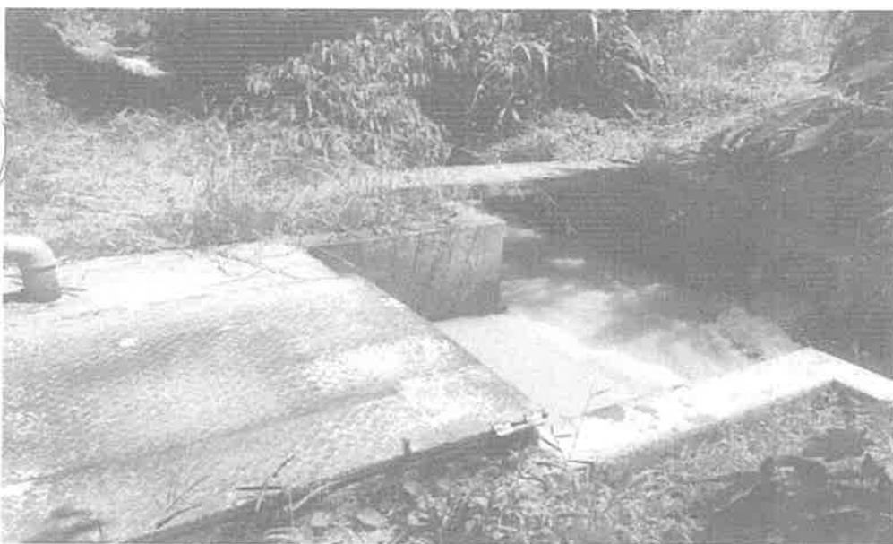
Imagen N°006: Infraestructura de Canal de las aguas turbinadas.
