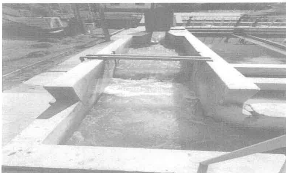
Imagen N°011: Canal Parshall de la PTAP Nueva
