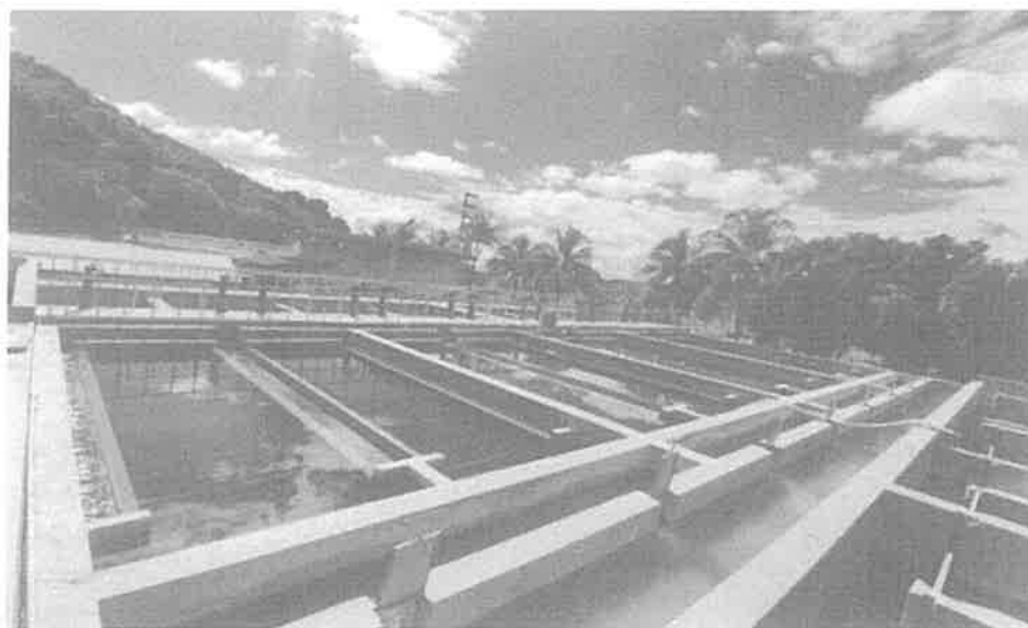
Imagen N°015: Decantador de la PTAP Nueva
