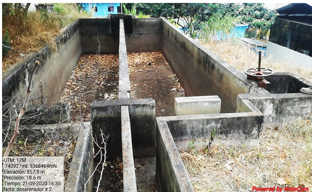
DESARENADOR (INOPERATIVO – ALTERNO PARA CANAL EL PROGRESO)
